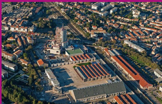
Site des Grands Ateliers (ex SNCF) à Arles (France) © Marc Heller
