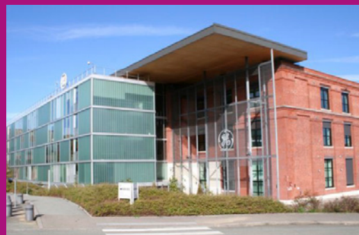
Reconversion (2003) de l'atelier de filature DMC en siège social européen de General Electric, Belfort (France) © Marina Gasnier
